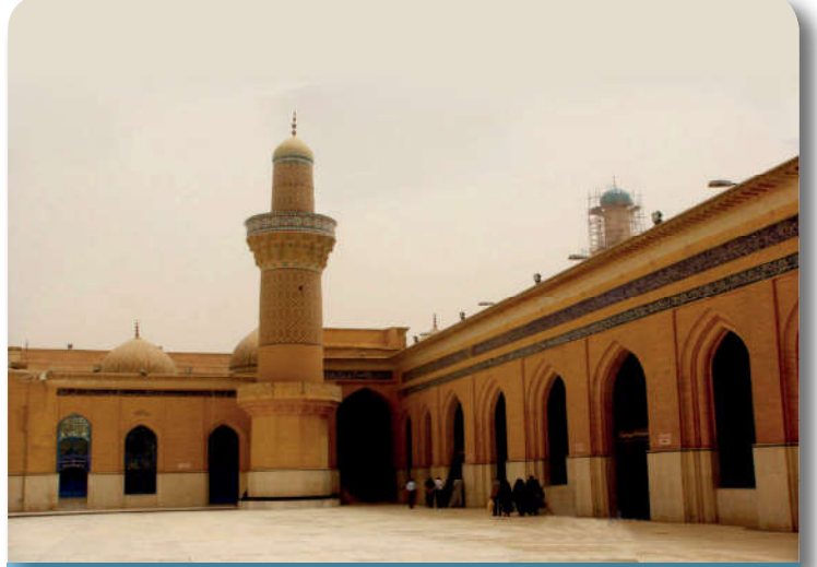
12.3.4. Abdülkadir Geylani Türbesi-Bağdat
